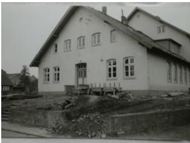
Altstadtschule in der Schulstraße
