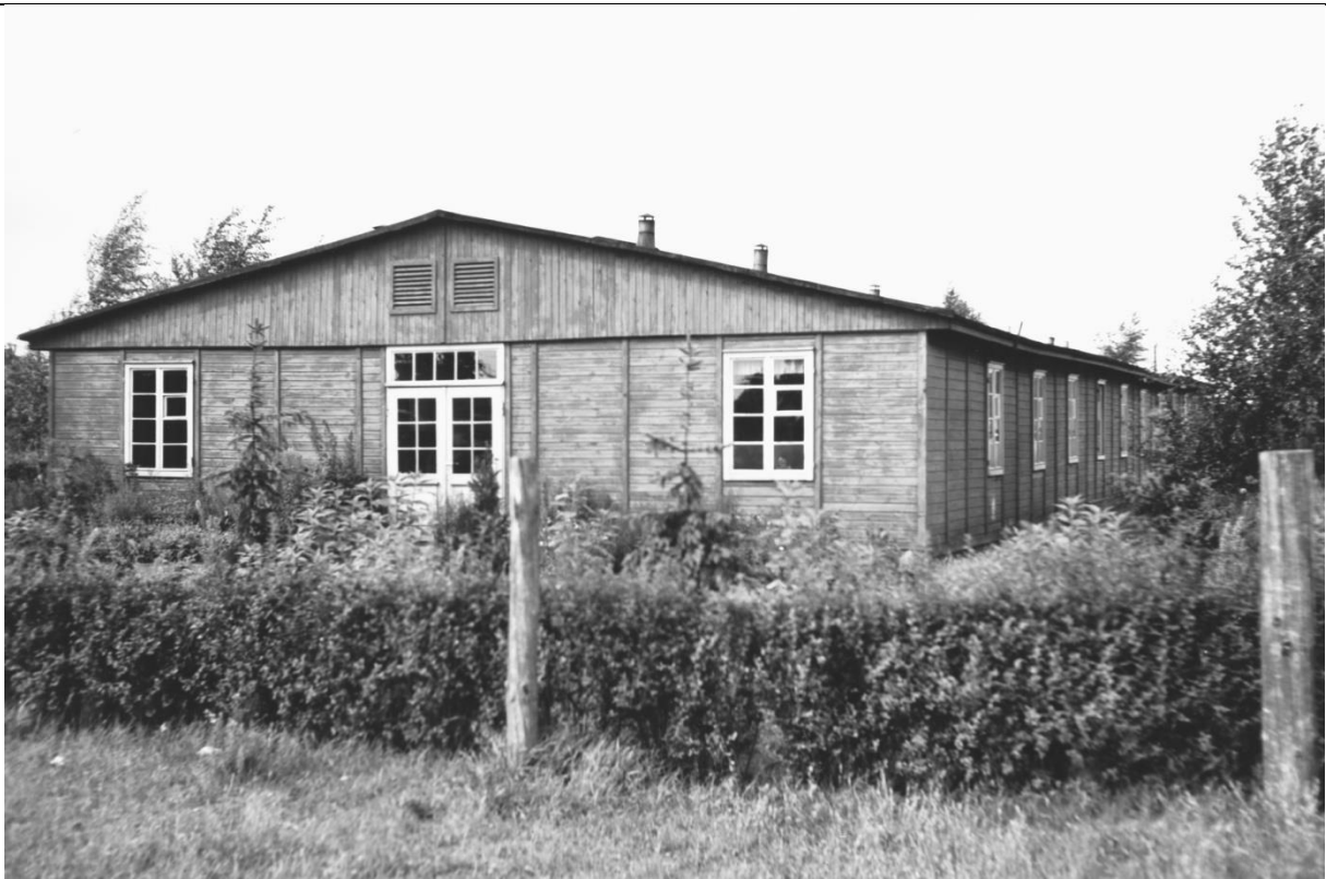
Baracke Mittelschule 1943/44 (Foto: Stadtbauamt Wedel)
