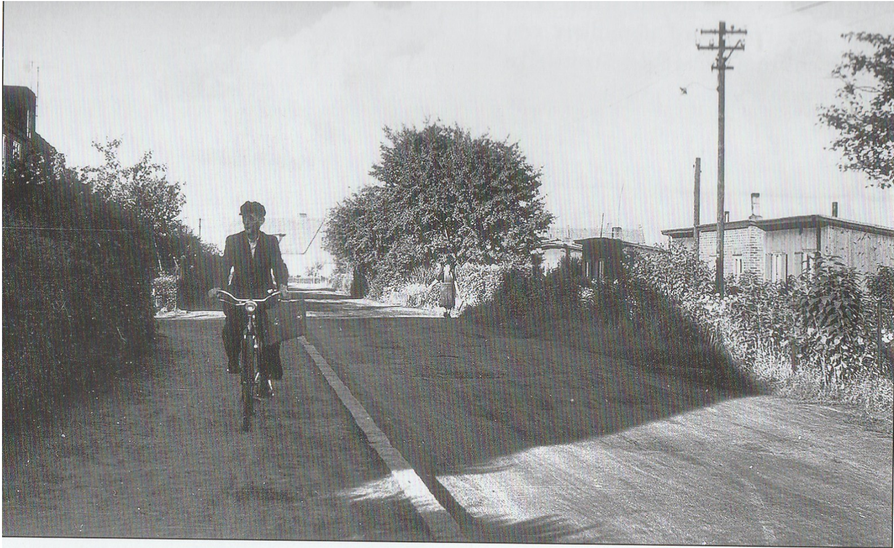
Baracken des Wohnlagers am Galgenberg, um 1954.
