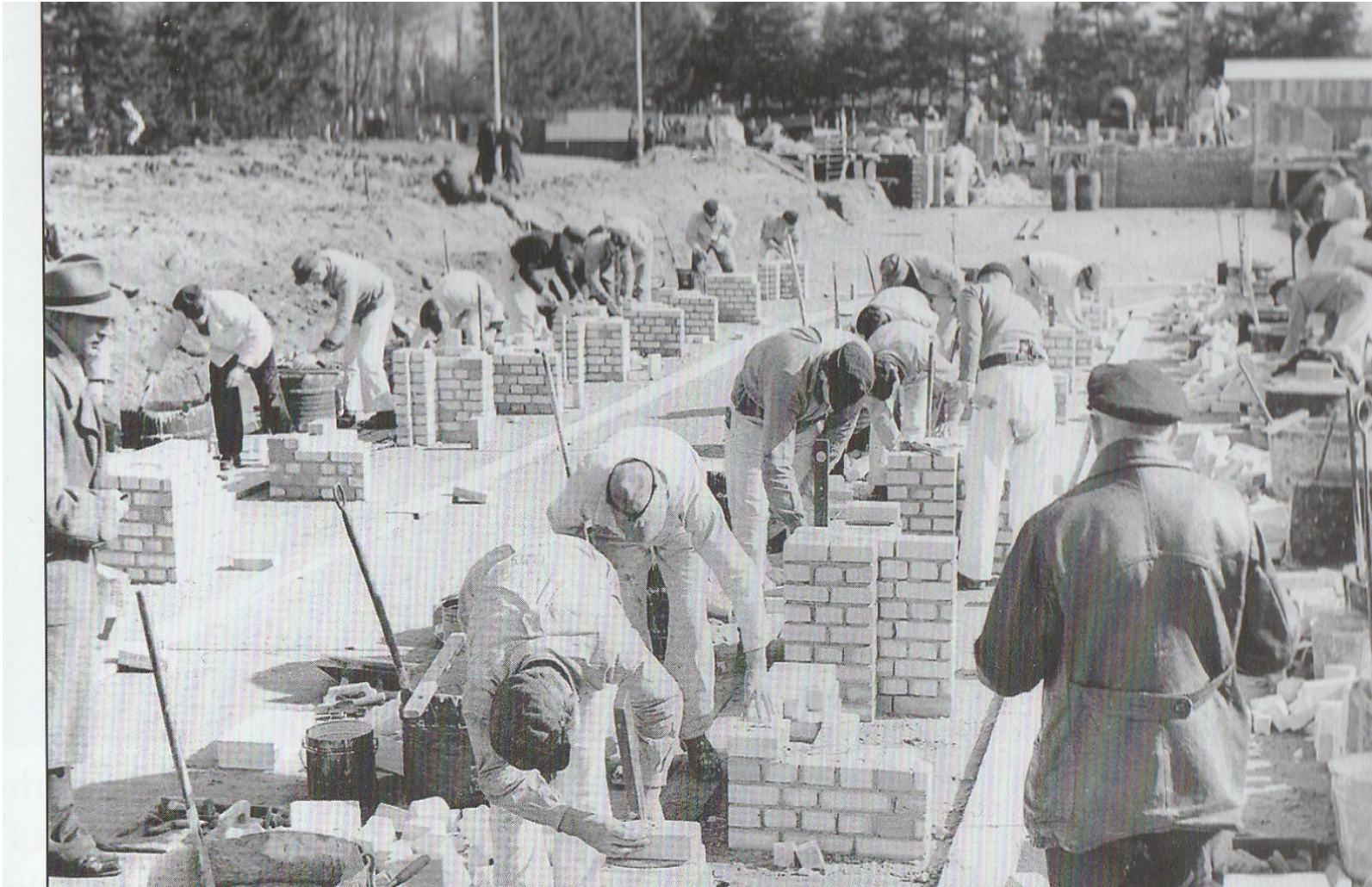
1950 Bauvorhaben Theodor Storm Schule
