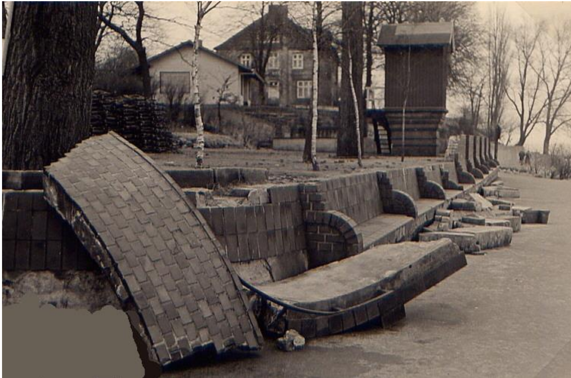
Kaputte Mauer mit Tiede- wasser, Blick Richtung Parnass 1962
