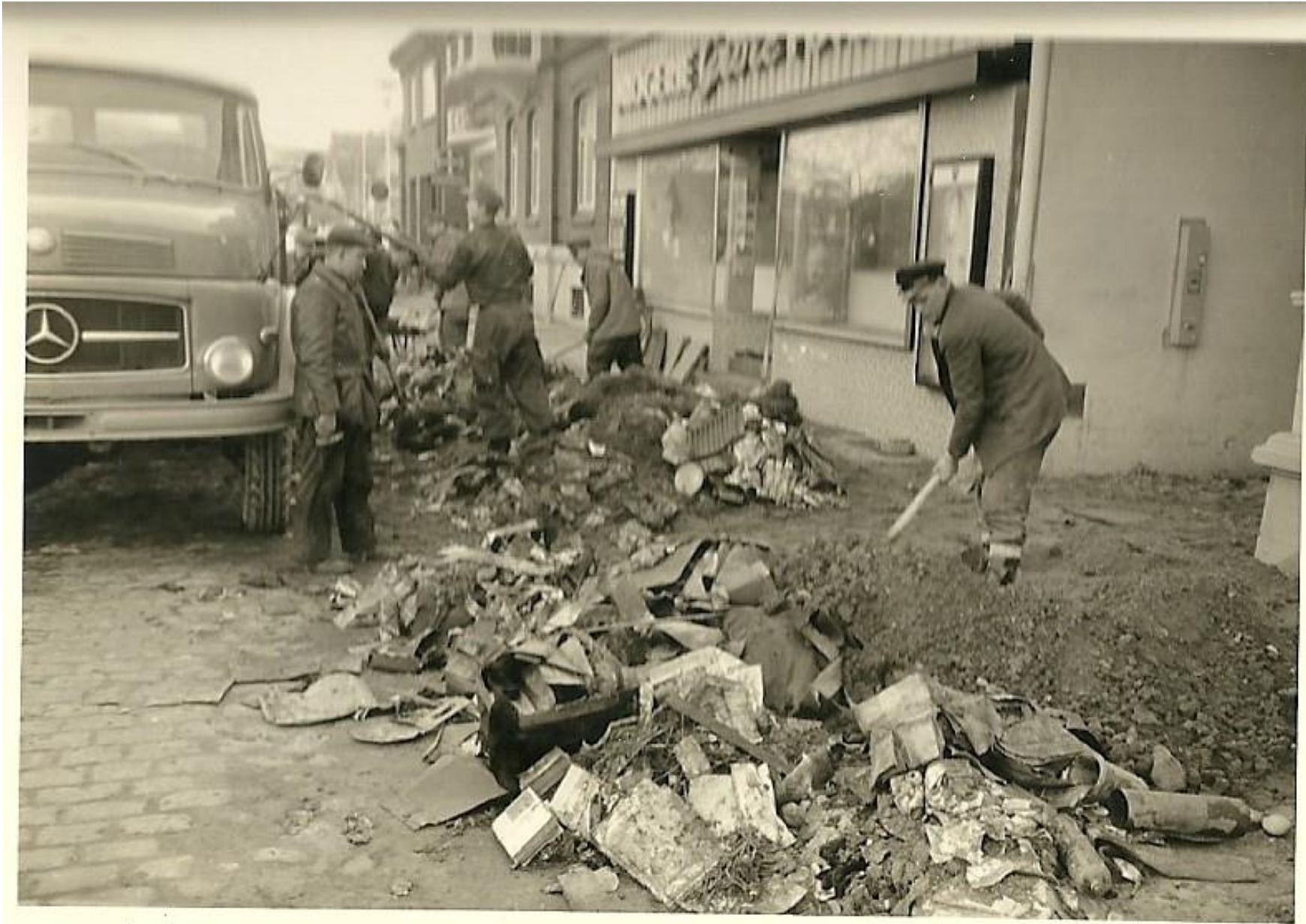
Aufräumarbeiten vor der Drogerie Grothe
