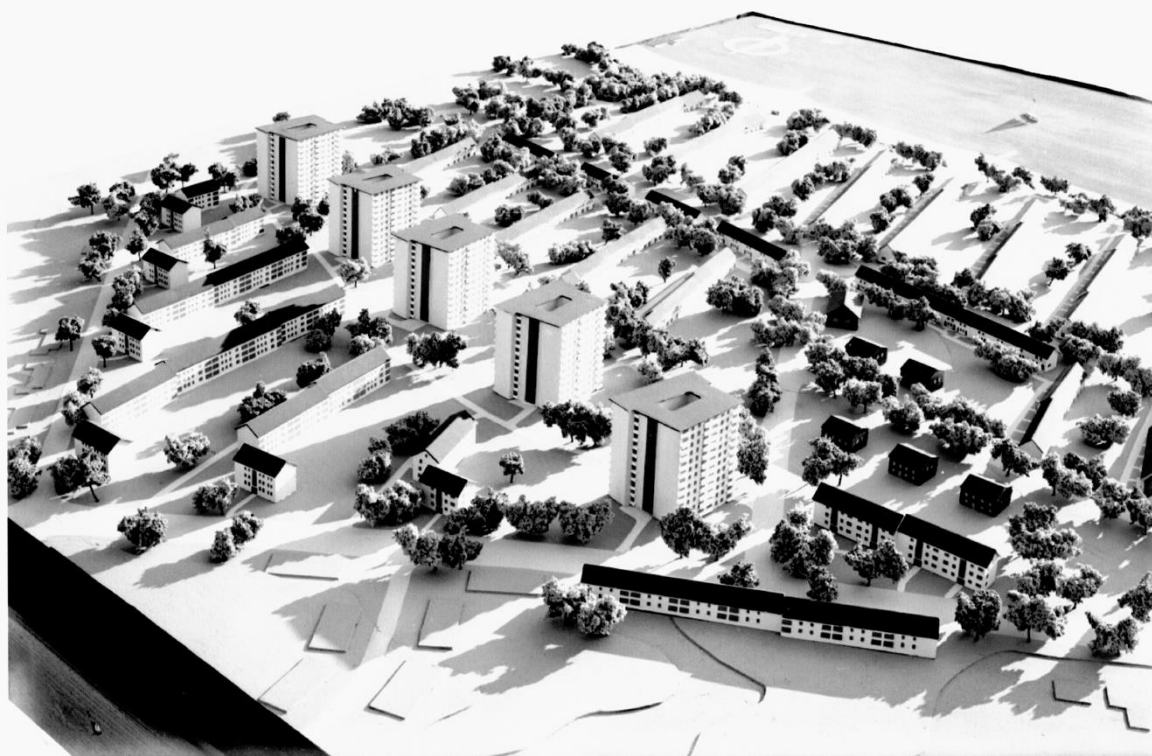
Die Gartenstadt Elbhochufer im Modell, 1953. Detailaufnahme der fünf Hochhäuser in einer späteren Version: Ihr Grundriß entspricht bereits dem des einzigen ausgeführten Hochhauses am Hans-Böckler-Platz. Quelle: Hamburger Architekturarchiv
