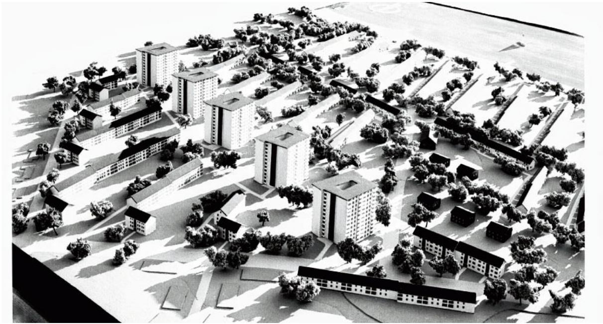
M MODELL EINE PLANUNGSVERSION MIT FÜNF HOCHHÄUSERN ENTLANG DER PULVERSTRASSE. WESENTLICHES MERKMAL DIESES ENTWURFES SIND DIE FÜNF ZWÖLFSTÖCKIGEN HOCHHÄUSER, DIE SICH AM ZU ERHALTENEN VERLAUF DER ELBSTRASSE BEFINDEN SOLLTEN, LETZTENDLICH WURDEN DIESE AUS KOSTENGRÜNDEN ABER NICHT GEBAUT (LINKS). STATT DES KONGRESSHOTELS WURDE DIE GRAF-LUCKNER-SENIORENRESIDENZ REALISIERT (UNTEN). HAMBURGER ARCHITEKTURARCHIV/JACOBSHAGEN
