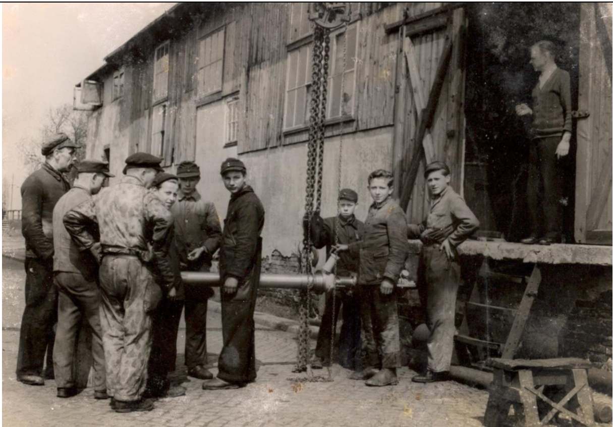
Gebäude im Schulauer Hafen, in dem später Propeller-Becker bis 1976 seine Edelstahlpropeller baute.
